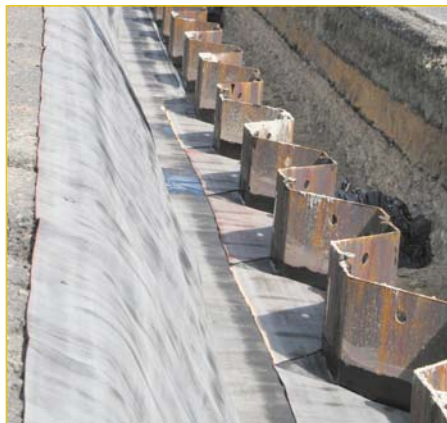
Mise en oeuvre de la géomembrane.
