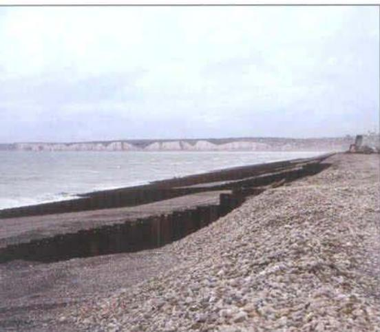
Les épîs mesurent 90 mètres de long et sont espacés de 90 mètres afin de former des alvéoles destinées à retenir les galets.
