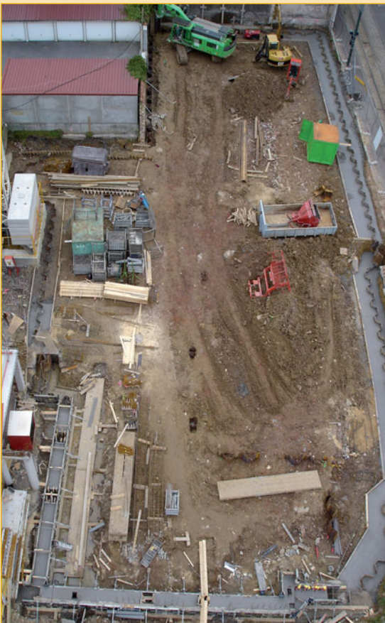
Complexité du tracé avant excavation
