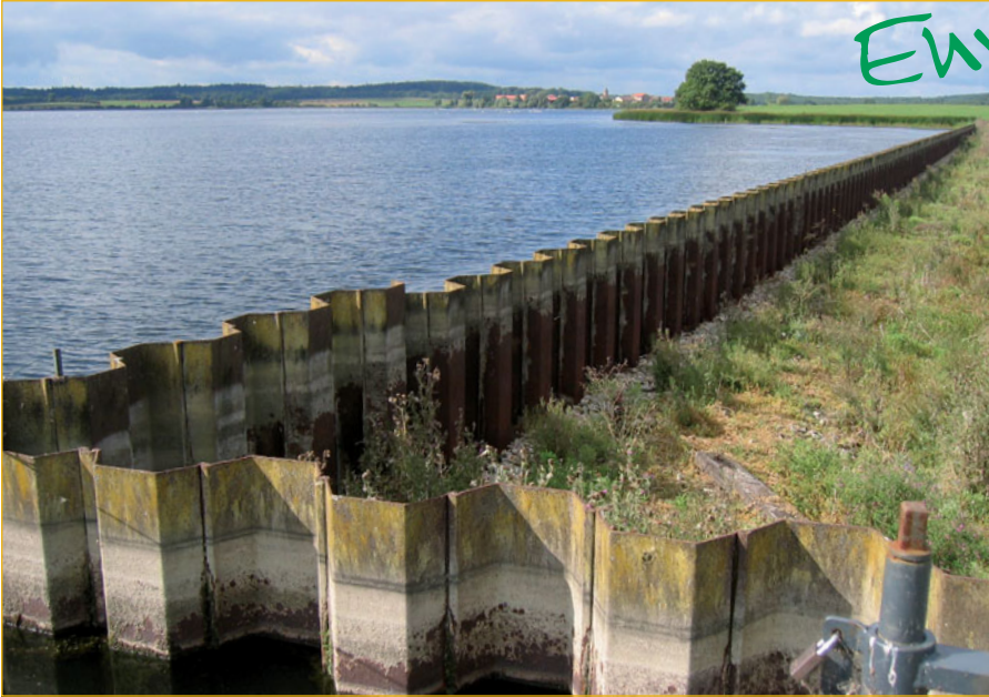
Digue en palplanches séparant l'étang
