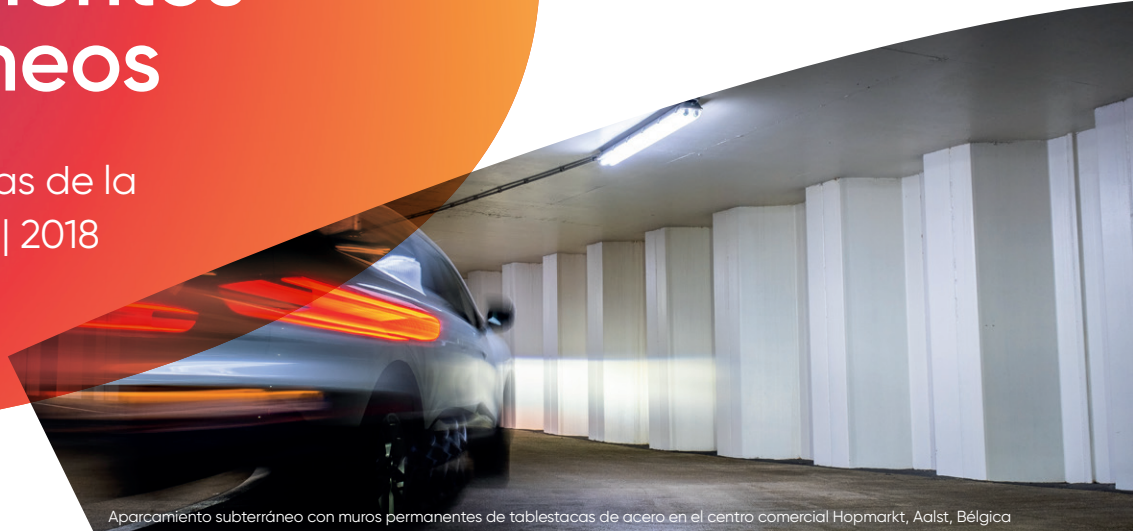
Aparcamiento subterráneo con muros permanentes de tablestacas de acero en el centro comercial Hopmarkt, Aalst, Bélgica
