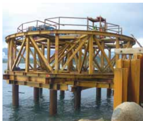
1. Installazione della dima
