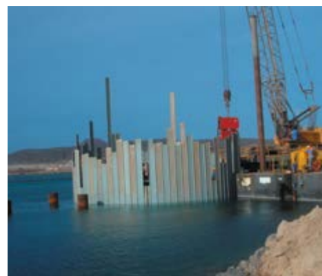
3. Cravação das estacas pranchas
