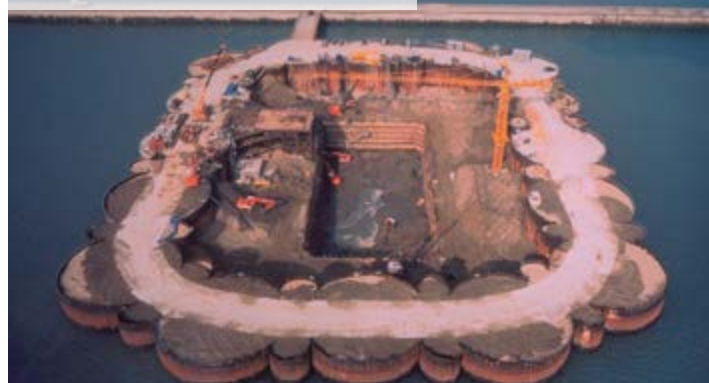
Construção de ponte, Coréia do Sul
