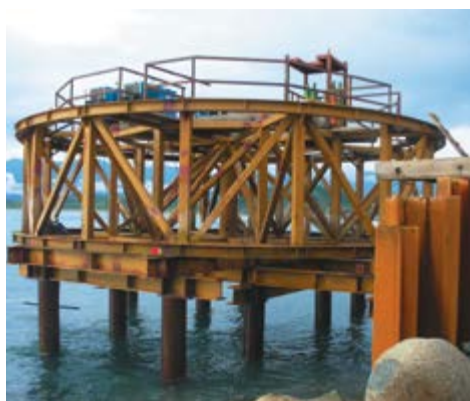
1. Instalação de matriz (template)
