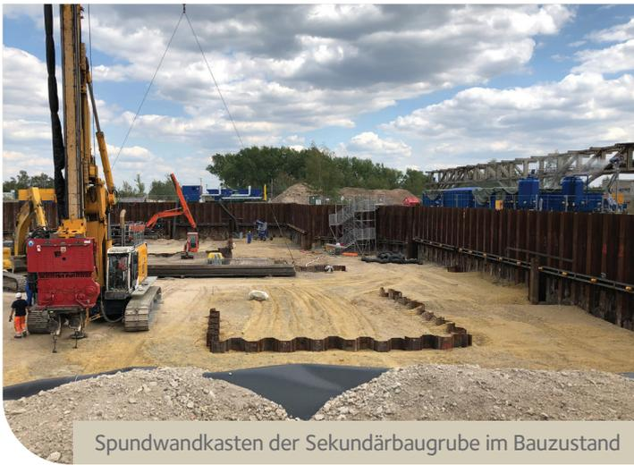
Spundwandkasten der Sekundärbaugrube im Bauzustand
