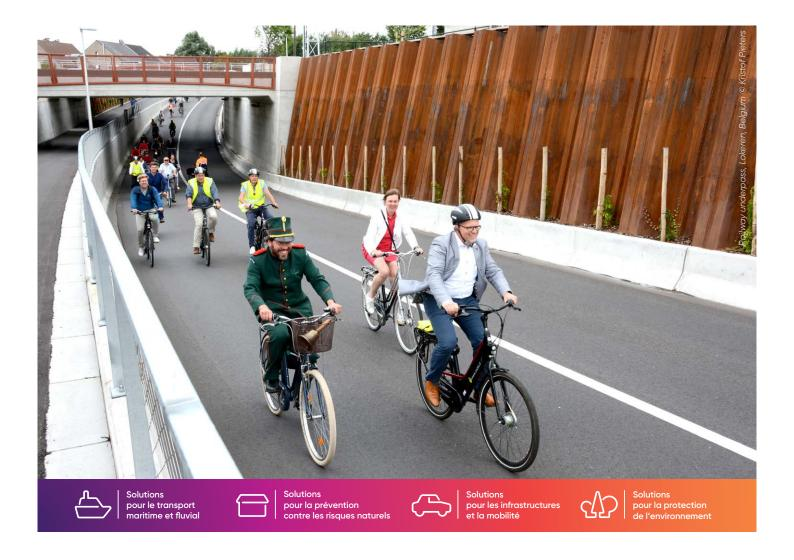
Les palplanches acier sont largement utilisées pour former des murs de soutènement pour les projets d'infrastructure, les ports et les voies navigables, ainsi que pour les transports urbains.
