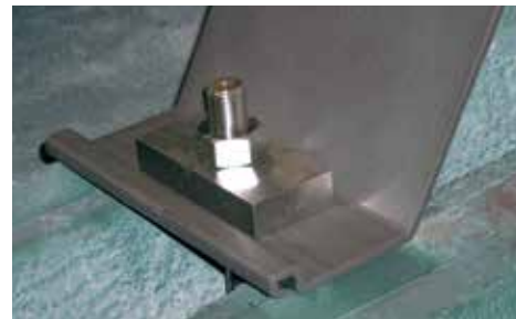
Richtige Anordnung der Ankerplatte
