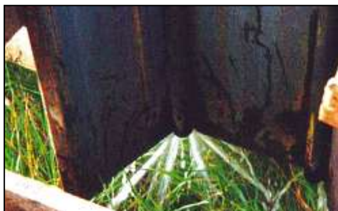
Foto 1: Fuß einer U-Spundbohle mit zwei in Betrieb befindlichen Spülrohren.
