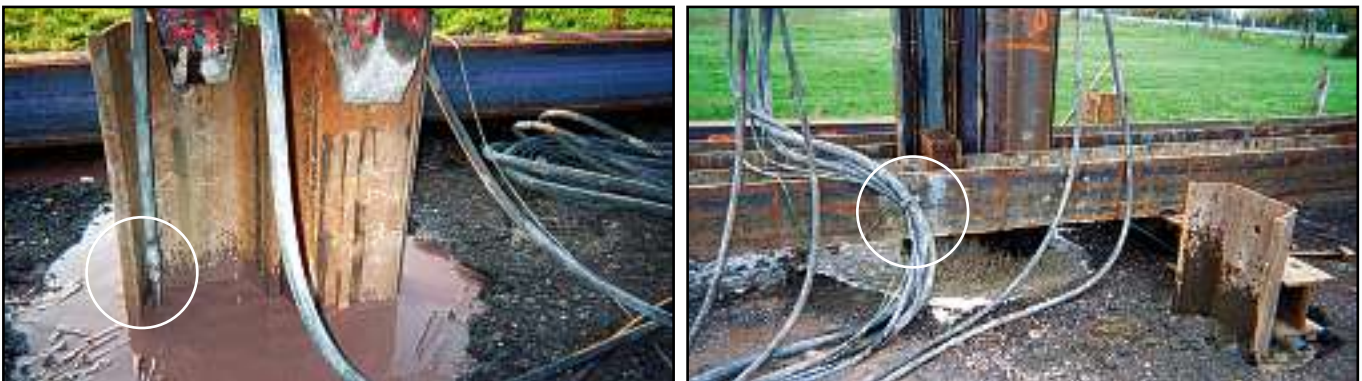
Ansicht der an die Spülrohre angeschlossenen Versorgungsschläuche (hier bei Ende des Einbringvorgangs)
