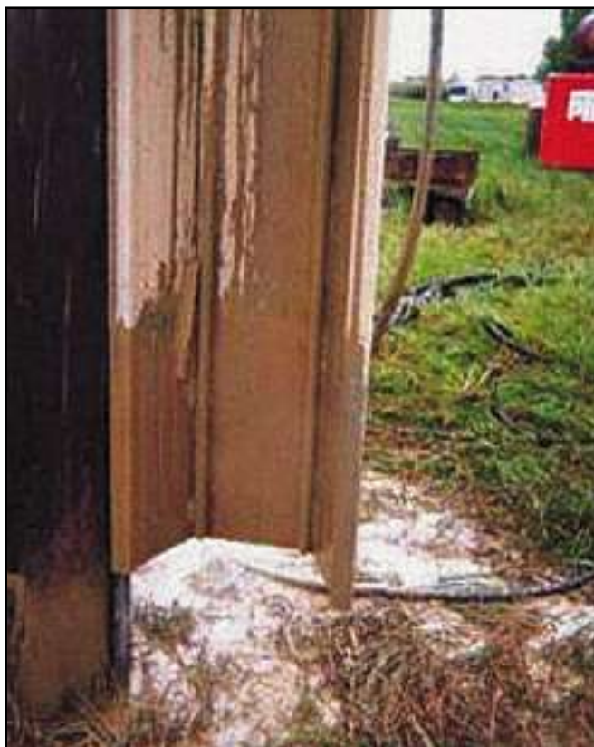
Foto 2: Ziehen einer U-Spundbohle nach dem Rüttelspülverfahren.
