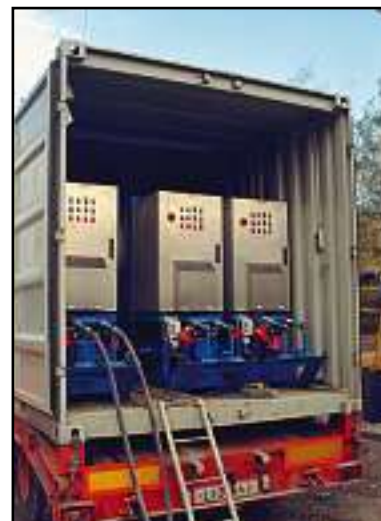
Bei einer großen Baulänge kann der Einsatz eines LKWs mit einem Container zur Unterbringung der Pumpen sehr wirtschaftlich sein
