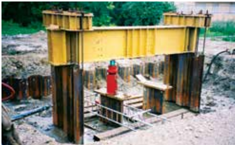
Beispiel einer Probelastung für eine Spundwand
