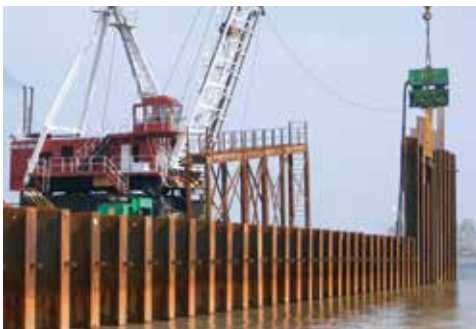
Vibrationsbär mit Verlängerung
