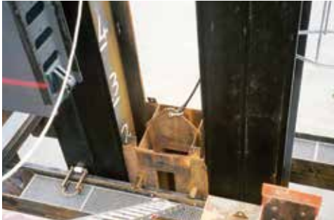
Als Sonderformen kann eine Vertikalführung zwischen zwei HZ ® -M Trägern Verwendung finden
