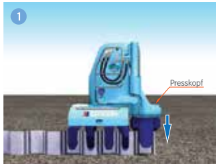
Die Spundbohle ist komplett eingepresst.
