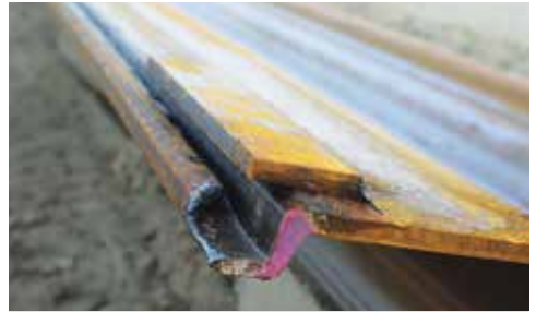
Flacheisen am Bohlenende
