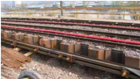
U-Bohlen mit Gurtung entlang einer Bahnlinie
