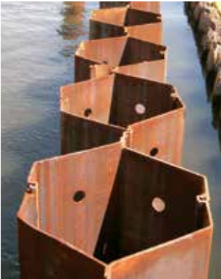
Fertiggestellte Wand aus AZ® Kastenpfählen (CAZ)
