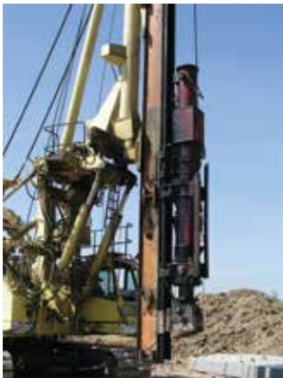
Dieselhammer am Mäklermast montiert und im Einsatz im Wandverbund
