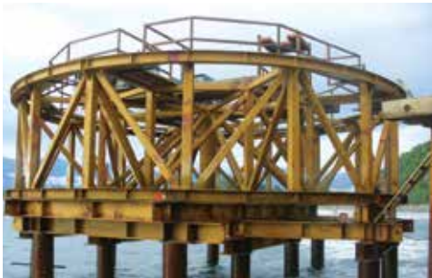
Führungsgerüst Hauptzelle
