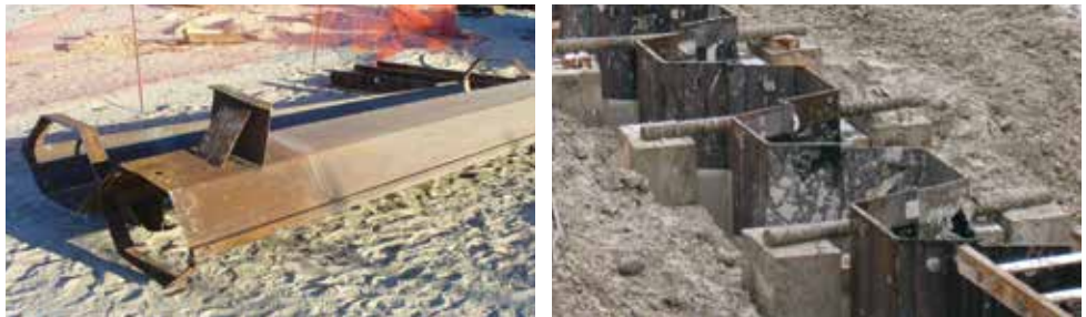
Haltevorrichtungen für eingestellte Spundbohlen
