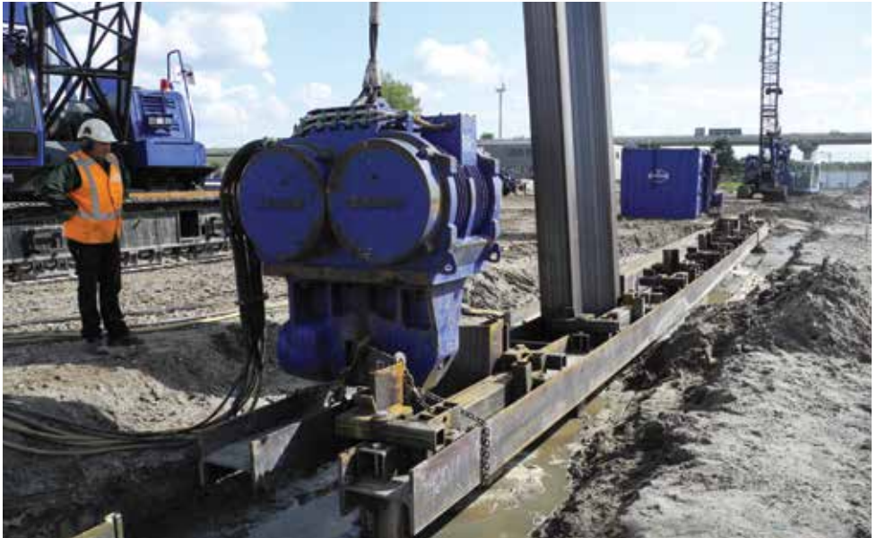
Verstellbare Rammführung
