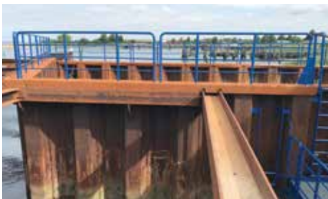
Abdeckung mit Stahlprofil
