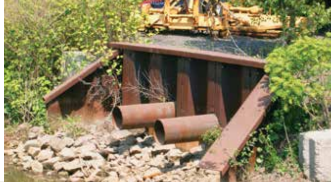
Beispiele zu Durchführungen durch Spundwände
