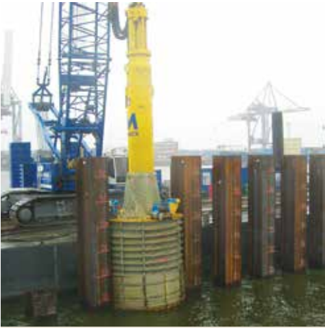
Schallschutzmassnahmen für Hammer (links) und Vibrationsbär (rechts)
