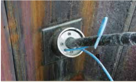
Wasserdichter Anschluss für einen Verpressanker
