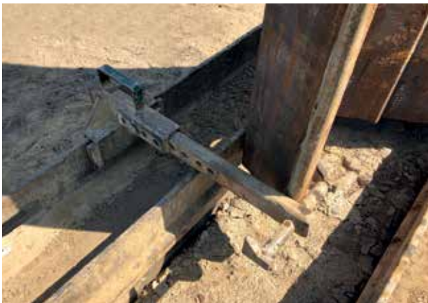
Beispiel für eine einfache Führungszange
