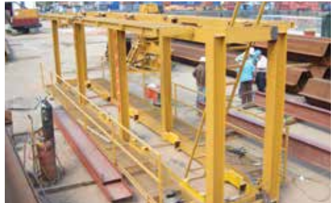
Beispiel für eine Führung für CAZ-Kastenpfähle
