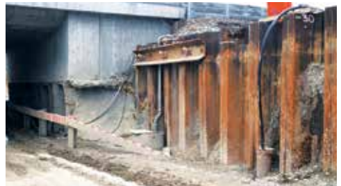
U-Profil als Gurtung für temporären Verbau
