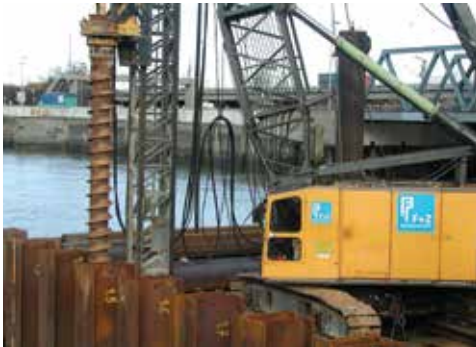
Vorbohren für Zwischenbohlen einer kombinierten HZ®-M Wand
