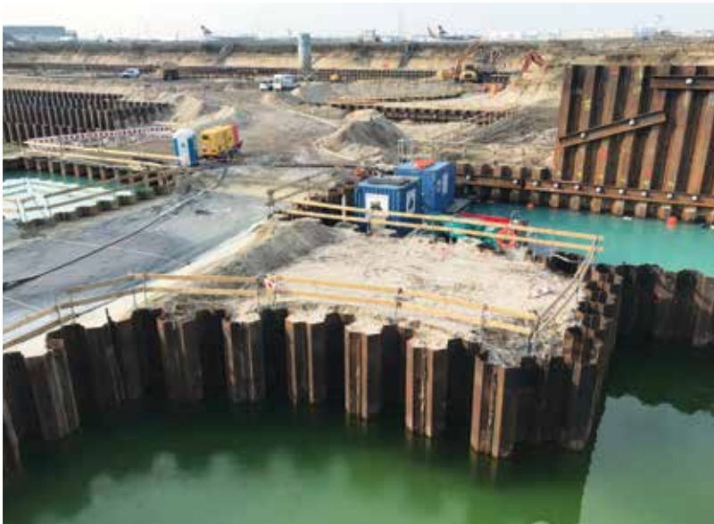
Spundwandarbeiten am Flughafen Frankfurt
