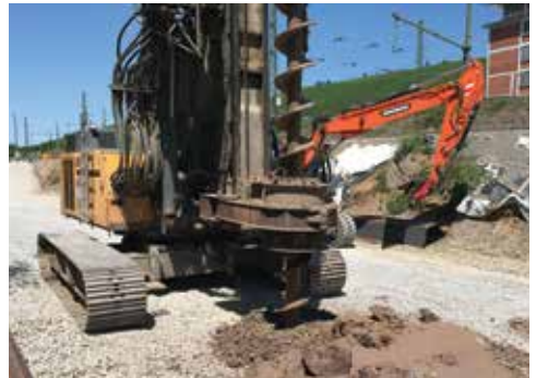
Bohrschnecke im Einsatz
