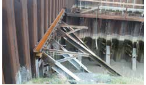
Schrägpfahlanschluss
