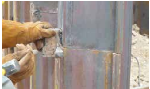
Ausrichten der korrekten Schlossposition um ein Ineinandergleiten der Profile zu erlauben
