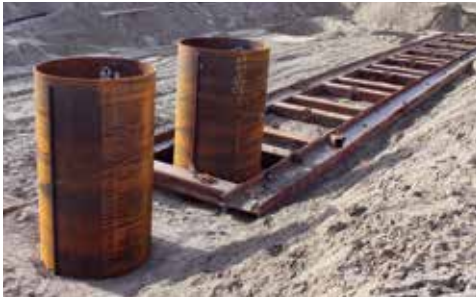
Beispiel für einen einfachen Führungsrahmen für Rohre
