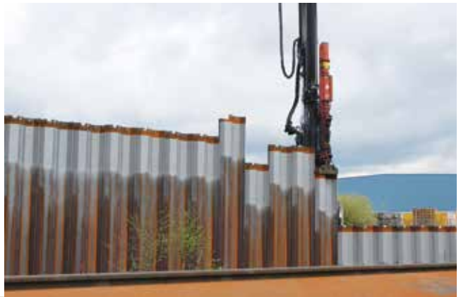
Dieselhammer am Mäklermast montiert und im Einsatz im Wandverbund
