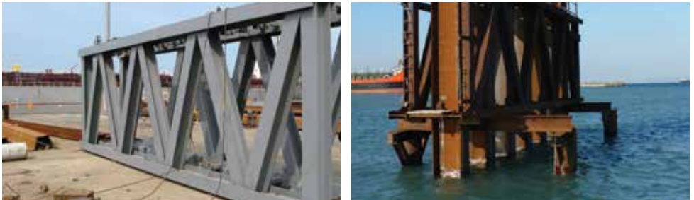
Beispiel einer Rammführung für eine kombinierte HZ®-M Wand, adaptierbar für verschiedene Tragprofile
