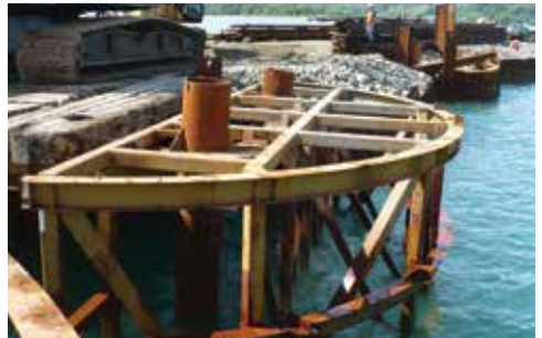
Führungsgerüst Zwickelzellen
