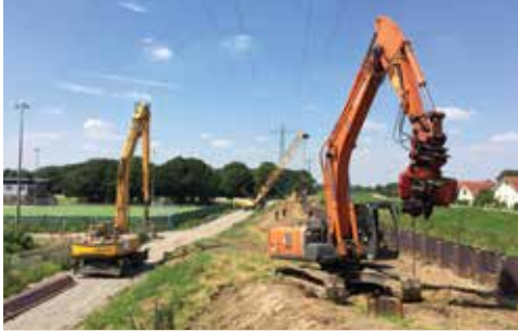
Baggeranbauvibrationsbär
