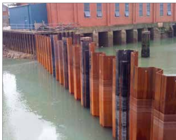
Abb. 12. Hafen von Shoreham, AMLoCor Stahlspundwand.
