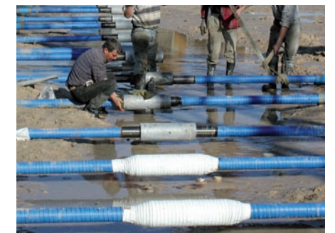
Application sur site du ruban adhésif sur les raccords
