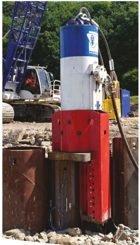
Im Vergleich zu Fallhämmer mit dem gleichen Gesamtgewicht ist der Kolben eines Schnellschlaghammers viel leichter. Das Gewicht beträgt nur 10-20% des Gesamtgewichts des Hammers, wird aber durch den auf der Oberseite des Kolbens wirkenden Druck von 5-8 bar wirkungsvoll verstärkt.
