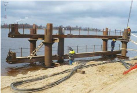
Schraubenbolzen müssen darüber hinaus angeordnet werden. Unmittelbar vor jeder zu rammenden Bohle sollte in Rammrichtung voraus ein Führungselement, bestehend aus Abstandshalter und Bügel, angeordnet werden. Das freie Flanschende bei Z-Bohlen bzw. das freie Schloss der U-Bohle sollte während der Rammung durch einen Führungsklotz gehalten werden, dies verhindert ein Drehen der Bohlen innerhalb der Führung.
