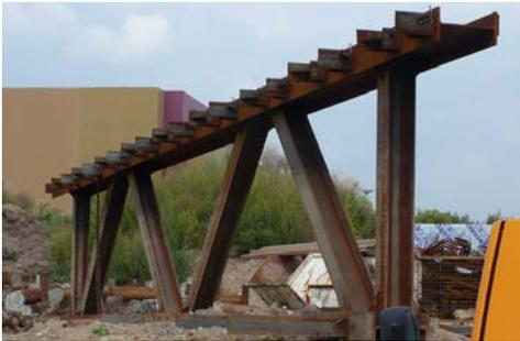
Eine nach vorne geöffnete Kammführung, greift nur die hinteren Flansche der HZ<sup>®</sup>-M Träger.
