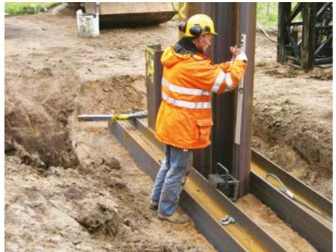
Für die Tragbohlen kombinierter Wände kann z.B. das nachfolgend beschriebene Messverfahren angewandt werden.
