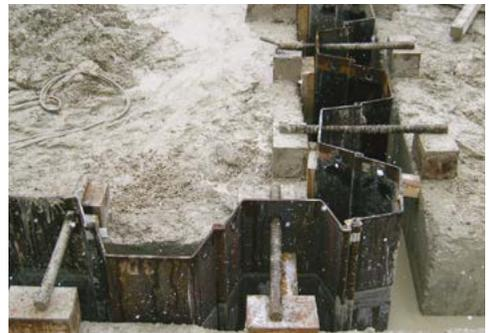
große Erschütterung hergestellt werden kann. Für wasserdichte und tragfähige Außenwände von Tiefgaragen oder für sichere und langlebige Einkapselung von Altlasten ist eine eingestellte Spundwand die beste Lösung.
