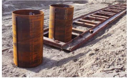
Beispiel für einen einfachen Führungsrahmen für Rohre
