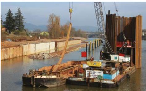
Bohlen bis etwa 15 m Länge können für das Einfädeln am oberen Ende angeschlagen werden. Das Anschlagen am Bohlenkopf kann über die normale Lieferlochung erfolgen. Bohlen größerer Länge sind zusätzlich in den Drittelpunkten zwei- oder dreimal anzuschlagen, um plastische Verformungen infolge Überbeanspruchung auszuschließen.
