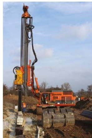
Tiefgaragen kommen Stahlelemente in „mixed-in-place“ Wänden zum Einsatz, um Langlebigkeit und Wasserdichtheit zu gewährleisten. Müssen Altlasten saniert und eingekapselt werden, kann man die sehr gute Wasserdichtheit der Spundwand mit dem Korrosionsschutz einer Bentonit-Zementsuspension kombinieren.
