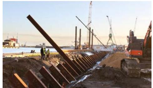
Schrägpfähle sind entweder reine Mantelreibungspfähle oder sie werden als Mantelverpresspfähle ausgebildet. Reibungspfähle sind in der Regel länger, Verpresspfähle können auf kürzerer Strecke mehr Last aufnehmen. Für beide Pfahlarten muss zur Bestimmung der tatsächlichen Tragfähigkeiten eine Probelastung durchgeführt werden, um die Annahmen der statischen Berechnung zu bestätigen. Bei reinen Mantelreibungspfählen ist eine eventuelle Verlängerung einfach durchzuführen.
