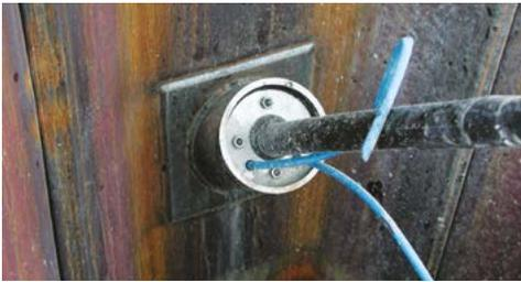
Wasserdichter Anschluss für einen Verpressanker
