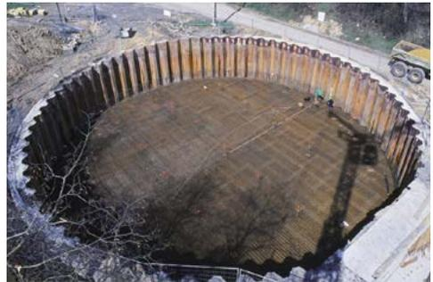
erlaubt. Zudem müssen U-Bohlen meist aus statischen Gründen als verpresste oder verschweisste Doppelbohlen verwendet werden, wodurch die Flexibilität der Doppelbohle weiter reduziert wird.
