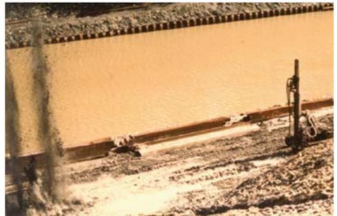
Um den größtmöglichen Nutzen aus diesem Verfahren zu ziehen, sollten die Stahlspundbohlen so bald wie möglich nach dem Sprengen in die gelockerte Zone eingebracht werden. Auch hier sind Fussverstärkungen sinnvoll.
