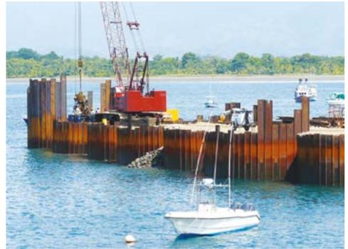
Nach Fertigstellung der Zelle muss sichergestellt werden, dass ungeeigneter Boden daraus entfernt wird, bevor mit gut verdichtbarem Material die Zelle gefüllt wird. Sobald die Füllung ein sicheres Niveau erreicht hat, wird das Führungsgerüst herausgehoben und zur nächsten Position versetzt.
