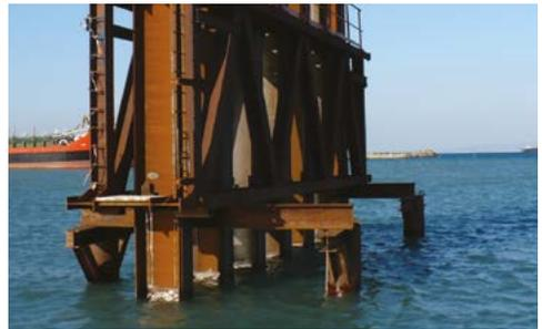
Beispiel einer Rammführung für eine kombinierte HZ -M Wand, adaptierbar für verschiedene Tragprofile
