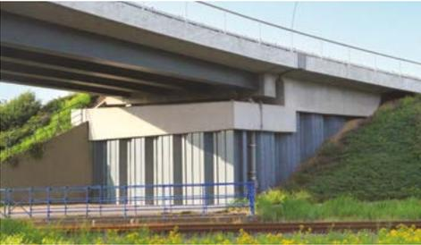
Brückenwiderlager mit planmässiger Einleitung vertikaler und horizontaler Kräfte
