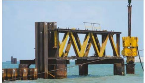
Führungsrahmen mit zwei Ebenen für das HZ -M System
