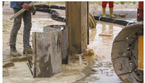
Im Allgemeinen wird Spülhilfe in Verbindung mit Vibration eingesetzt. Durch die verminderte Reibung kann auch mit kleineren Geräten eine gute Einbauleitung erreicht werden. An einer Spundwanddoppelbohle werden zwei bis vier Lanzen von etwa 1" Durchmesser möglichst stabil befestigt und mit je einer Pumpe von etwa 20 bar Leistung
