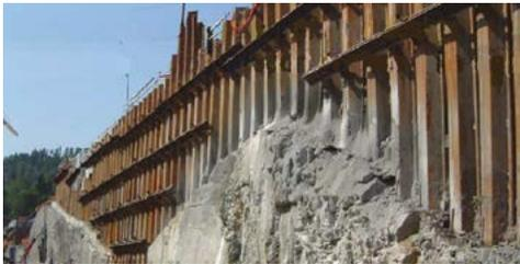
Wenn Einrammen in den Fels nicht möglich ist, kann durch Felsdübel („Rock Bolts“) ein ausreichendes Fussaflager ausgebildet werden. Die Spundbohlen werden vor dem Einbau mit Rohren, Durchmesser 8–10 cm, bestückt. Nach dem Abteufen auf Endtiefe, oder wenn kein weiteres Eindringen in den Boden möglich ist, wird durch das angeschweißte Rohr mit einer Bohrlafette in den anstehenden Fels gebohrt.
