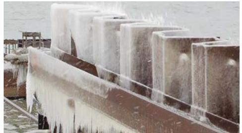
Werden Spundwandprofile im Winter bei dauerhaft tiefen Temperaturen unter  $-5^{\circ}\text{C}$  eingebaut oder in arktischen Regionen eingesetzt, sind besondere Empfehlungen zu beachten. Der Stahl soll mindestens der Güte S355GP oder höher entsprechen und Kerbschlagzähigkeitswerten von mindestens 27 kJ bei  $-20^{\circ}\text{C}$  aufweisen. Je nach Bodenverhältnissen soll das Widerstandsmoment der Spundbohle nicht kleiner als  $1800\text{ cm}^3/\text{m}$  sein.
