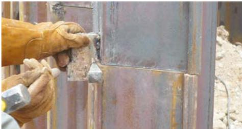
Ausrichten der korrekten Schlossposition um ein Ineinandergleiten der Profile zu erlauben
