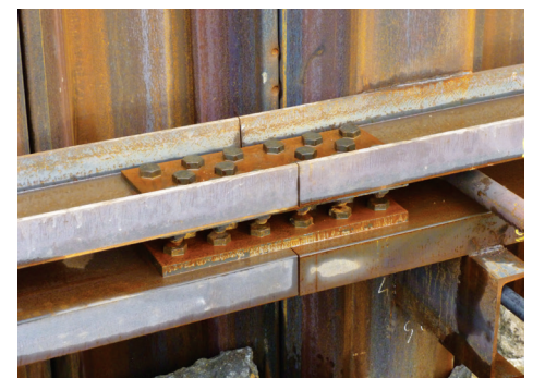
Détail de raccordement des liernes
