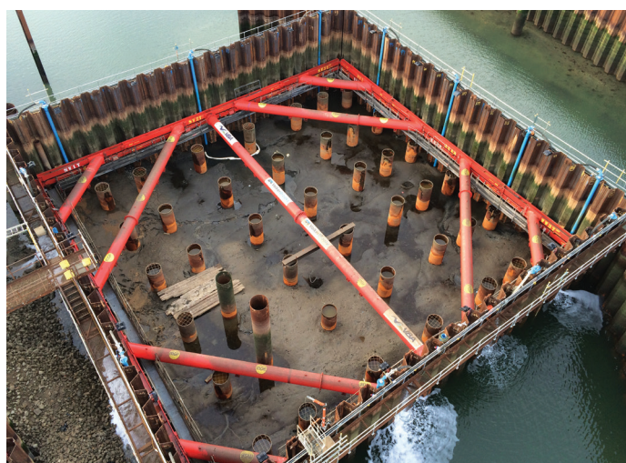
Barrière anti-crue à Ipswich, Royaume-Uni | ©MGF
