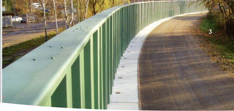
navigable devrait être élargie, il est possible, grâce au rideau de palplanches, de passer d'un profil en trapèze à un profil à angle droit. (ill. 3a, 3b, 3c)
