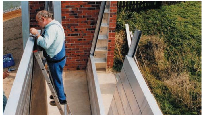
Surélévation de la digue à Zons (Allemagne) – fermeture temporaire d'ouvertures dans la protection permanente anti-crue
