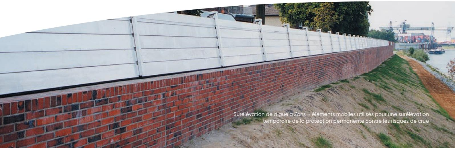
Surélévation de digue à Zons – éléments mobiles utilisés pour une surélévation temporaire de la protection permanente contre les risques de crue
