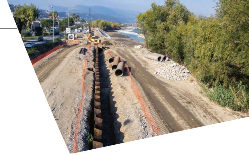
Amorcé en juillet 2016, le confortement des berges comprenait également la mise en œuvre de protections en enrochements et en matelas de gabions, le réaménagement des exutoires des ouvrages hydrauliques pluviaux et les aménagements paysagers, créant un espace végétalisé tout le long de la digue.
