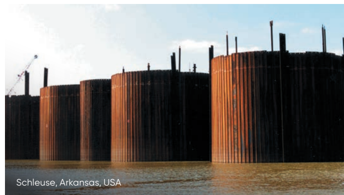
Flachzellen mit 120^\circ Abzweigbohlen.
