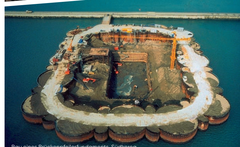
Bau eines Brückenpfeilerfundaments, Südkorea
