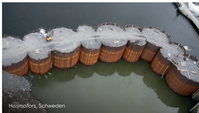
Kreiszellen mit 35^\circ Abzweigbohlen und einer Zwickelwand oder zwei Zwickelwänden.
