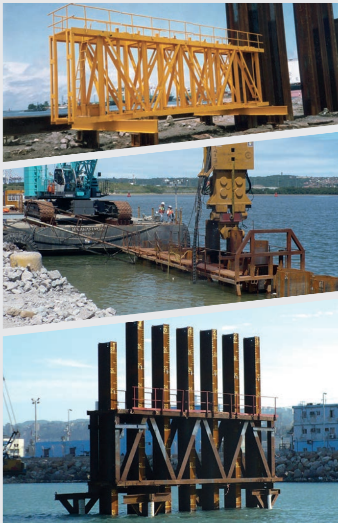
Abb. 16. Rammgerüste und deren Unterstützung.
