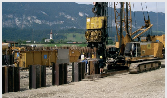
Abb. 18. Rammgerüst mit einer einzigen Ebene und Mäklführung.
