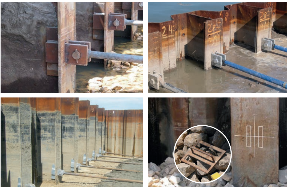
Abb. 27. Einbringen der T-Verbindern auf der Baustelle.
