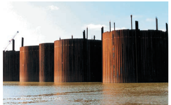
Cellule a diaframma con pile di giunzione a 120^\circ .
