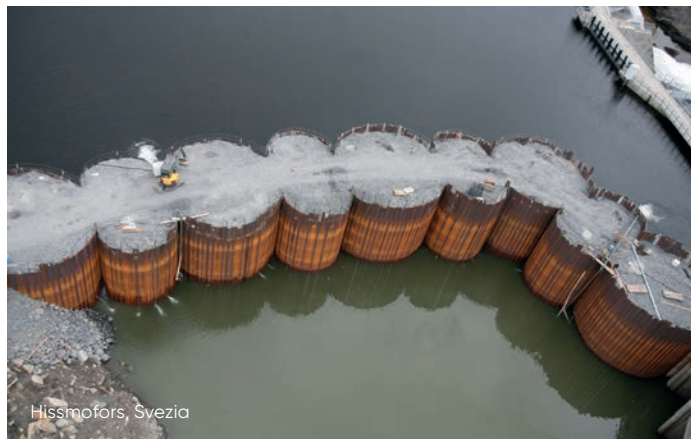
Cellule circolari con pile di giunzione a 35^\circ e uno o due archi di collegamento.
