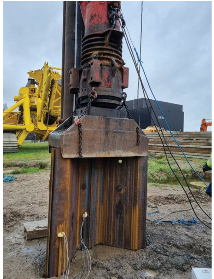
Einrammen der mit Messgeräten ausgestatteten Spundbohle A mit einem Diesel-Rüttelhammer (Phase 2)
