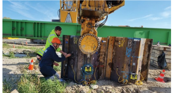
Einrammen der Spundbohlen A und B mit einem Vibrationshammer (Phase 1)
