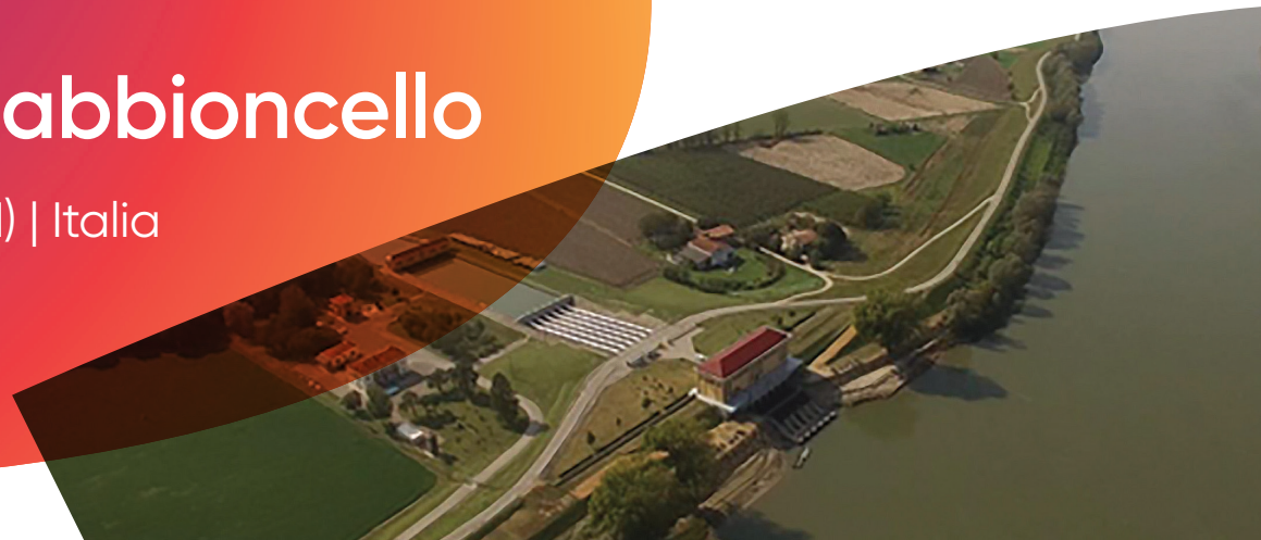
Canale Sabbioncello alla derivazione del Po
