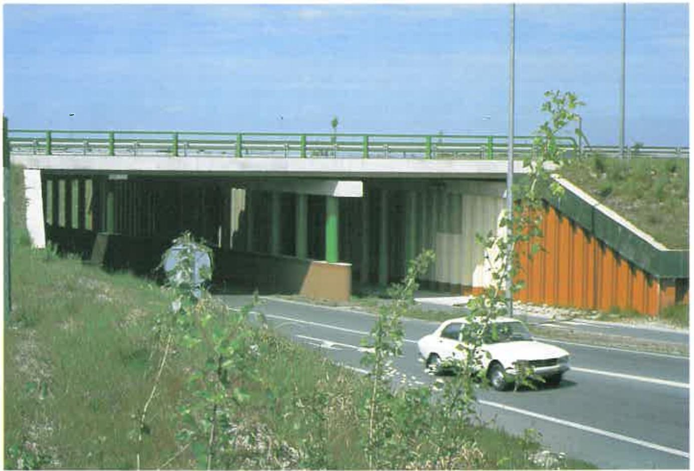
sés en palplanches. Pour les rideaux des culées on note l'absence de système d'ancrage, le tablier du pont faisant office de bouton permanent. L'étanchéité de l'ouvrage est complétée par des écrans latéraux.
