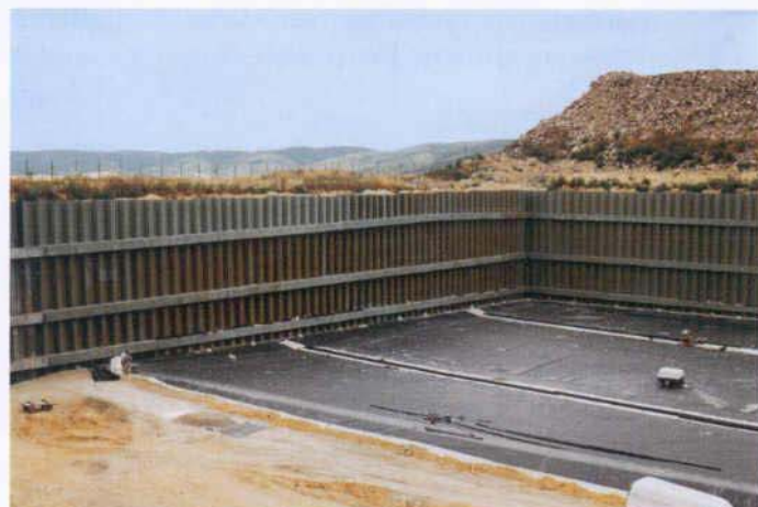
Réhabilitation d'une ancienne décharge. Volume gagné : 130.000 m 3 .
