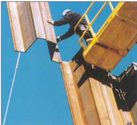
Enclenchement des paires d'AZ 48 à partir d'une plate-forme élévatrice.
