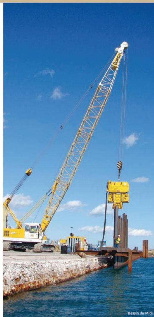
par une nappe de tirants passifs, elle-même reliée à un massif en béton et à un réseau de palplanches d'ancrage. Ces quais, gravement endommagés par l'érosion marine, avaient besoin d'être rénovés pour donner une nouvelle identité au site (ils accueilleront notamment les thoniers en période hivernale).
