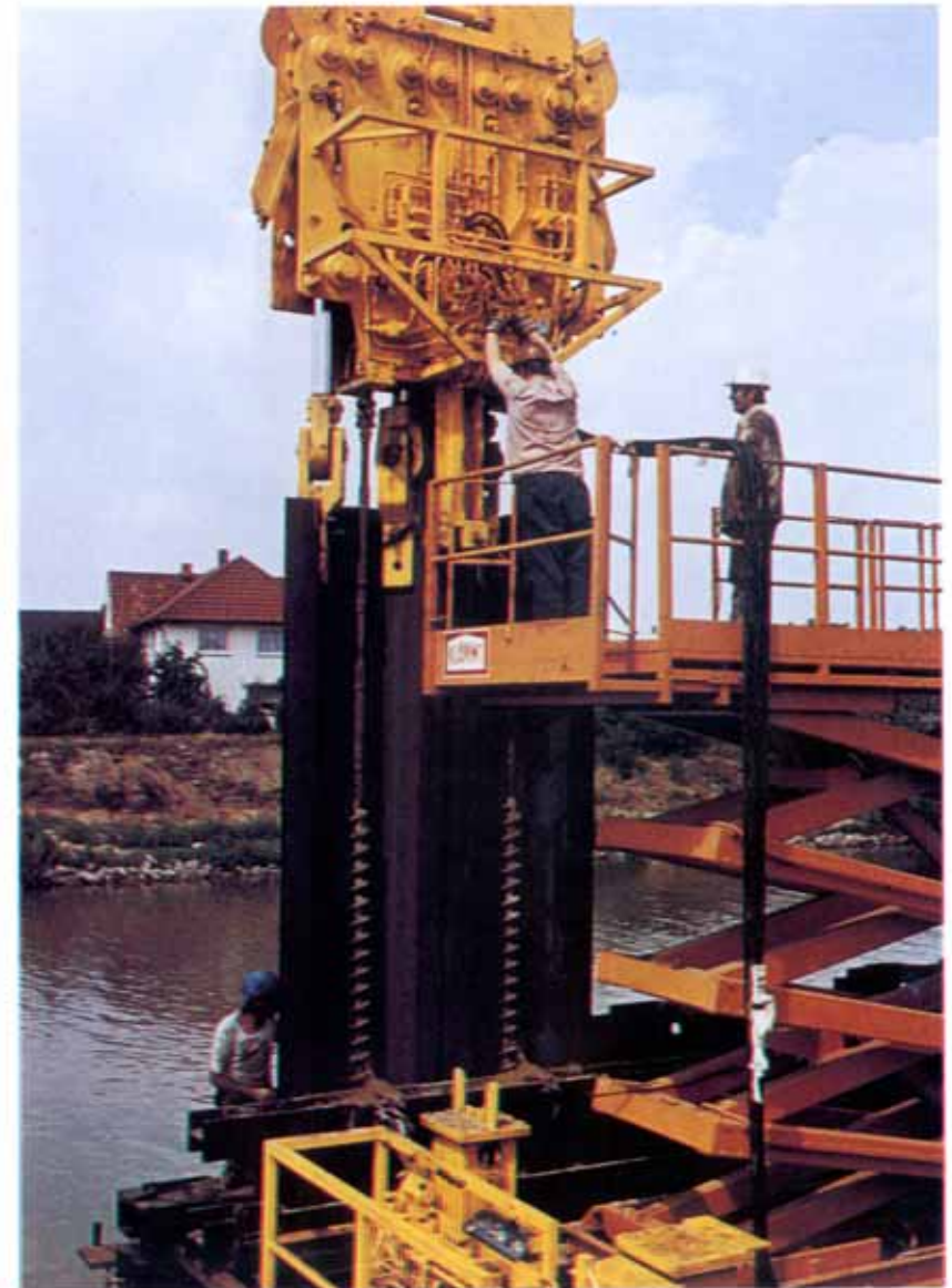
Figure 3.7-2: PRESSE POUR PALPLANCHES (Type 2) Système Klammt
