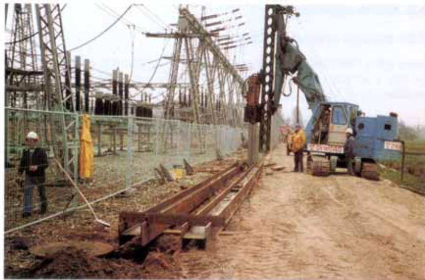
Figure 6.2.1-4: TREPIDEUR SUR MÂT DE GUIDAGE
