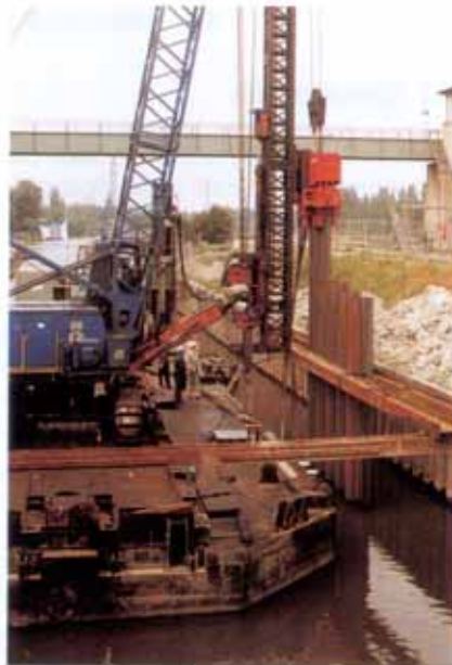
Figure 6.2.1-3: VIBRATEUR MONTÉ SUR MÂT DE GUIDAGE
