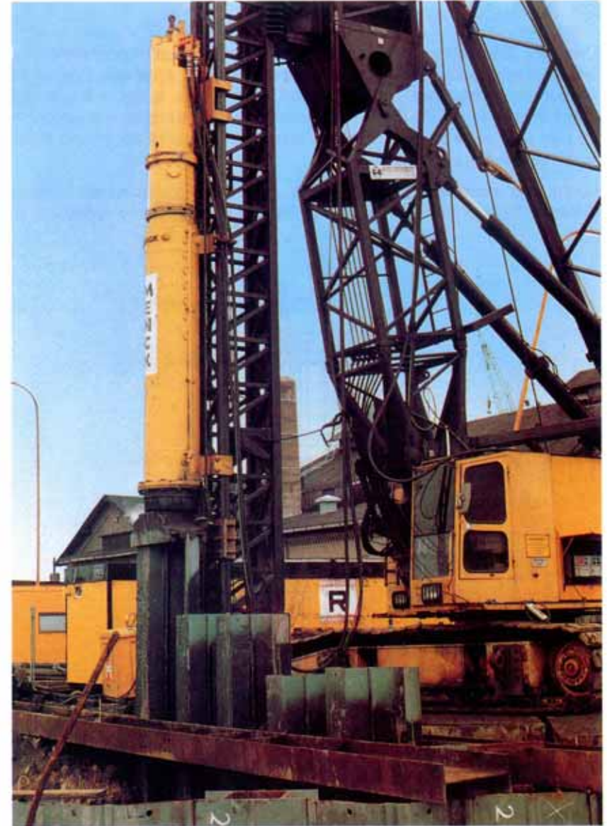
Figure 3.4-2: MOUTON HYDRAULIQUE À DOUBLE EFFET
